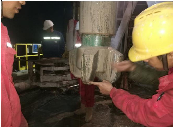
现场施工照片
