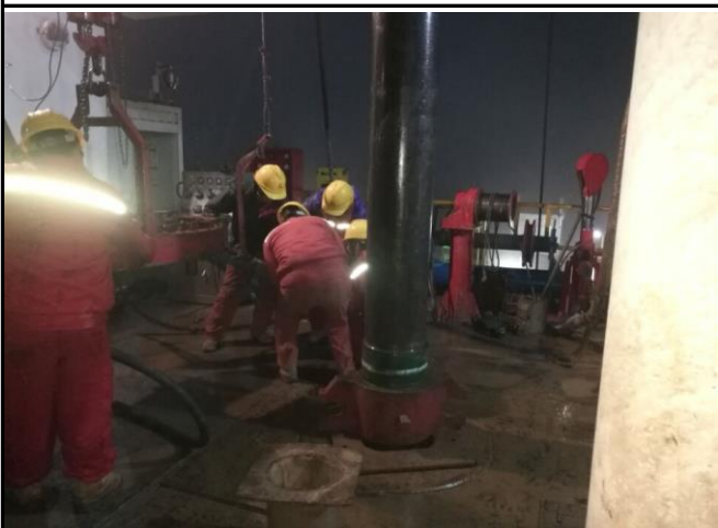
现场施工照片
