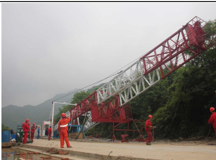
陕南地1井设备安装现场
