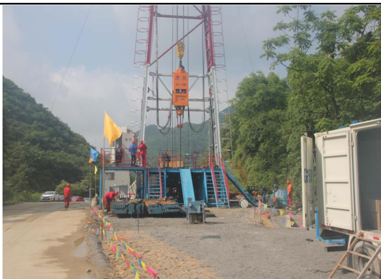
陕南地1井设备调试现场
