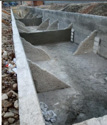
图表 1:岩屑池隔离整改完毕
