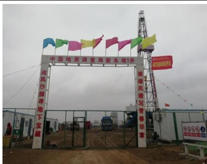
新永地1井现场照片
