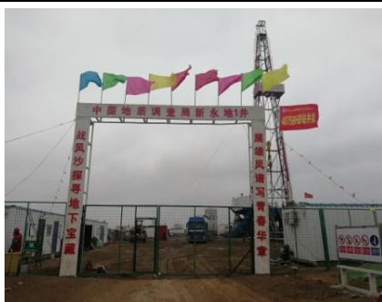
新永地1井现场照片
