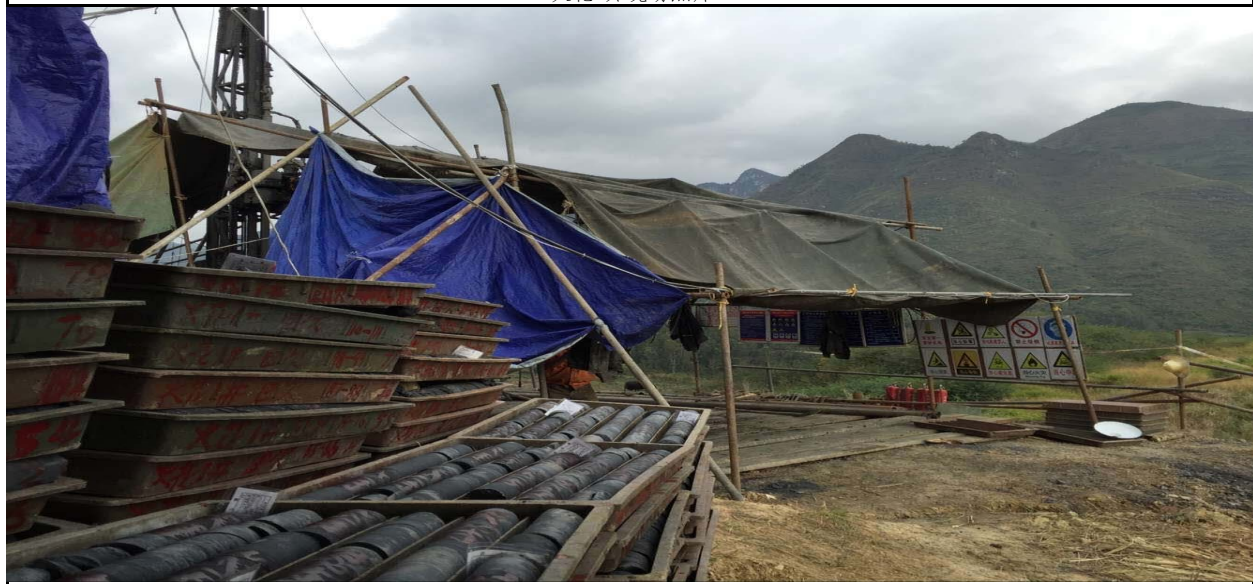
火花1井现场照片
